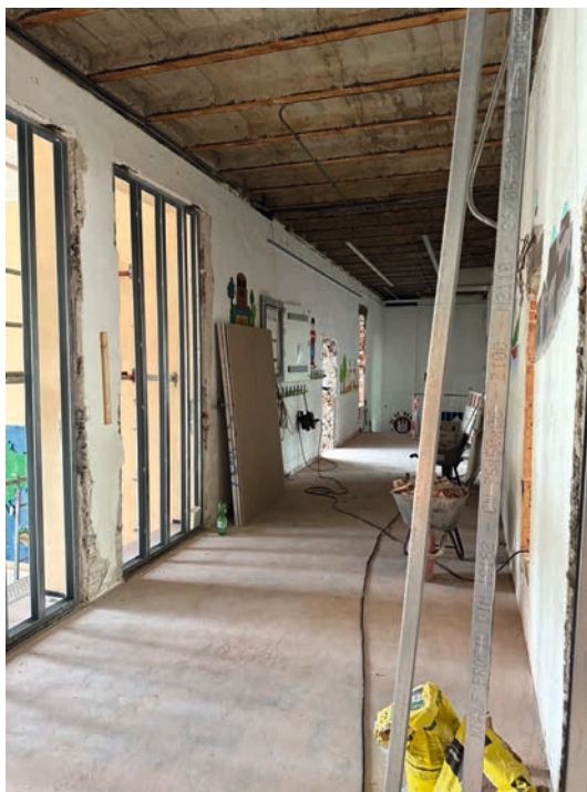
Kaum wiederzuerkennen: Die Schule Hochallee ist vorübergehend gesperrt und wird umfangreich saniert.
